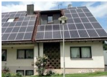
Autarklösung mit Wärmepumpe + PV
