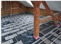
Alu-Fußbodenheizung von WALTER® für Altbau-Sanierung mit nur 3 cm Aufbau!
