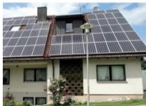
Autarklösung mit Wärmepumpe + PV
