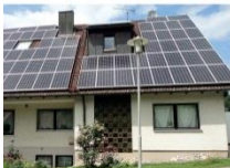
Autarklösung mit Wärmepumpe + PV
